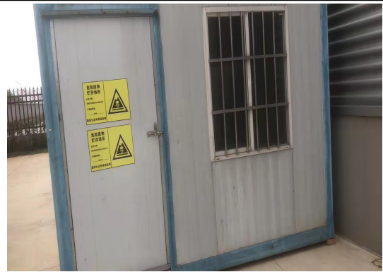
危险贮存设施
